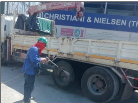
ภาพที่ 8 พื้นที่ทำความสะอาดล้อรถบรรทุก
